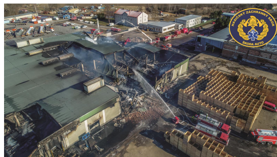
Obr. 9 – nasazení UAV HZSp Škoda Auto při organizaci místa zásahu požáru bývalých mrazíren v Mochově [17]
